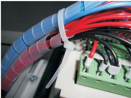
После прокладки всех проводов к клеммам МКЗ, стяните получившийся жгут кабельной стяжкой.
